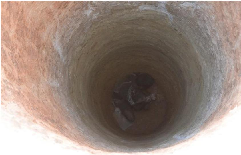
Wer genau hinsieht, erkennt einen Mann auf dem Boden des Schachtes, der per Hand Erdschicht für Erdschicht abträgt, um den Brunnen tiefer und tiefer in die Erde zu treiben.
